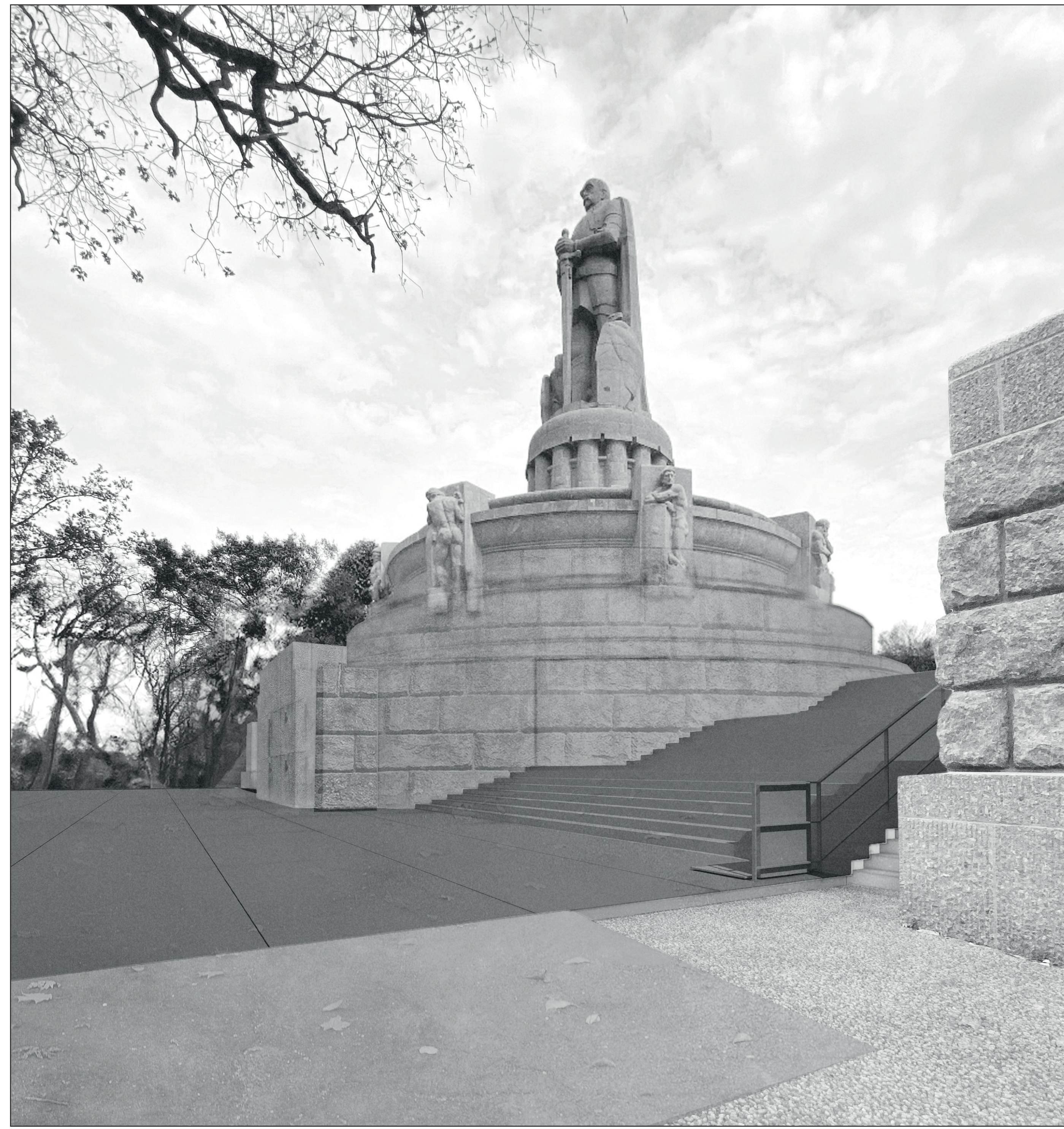
Abbildung 4: »Plattform« am Bismarckdenkmal, Gussseisenplatten auf Unterkonstruktion, 46,25 x 46,25 x 4,20m (Gesamthöhe)
